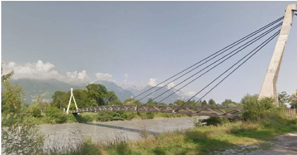
Passerelle mobilité douce à Illarsaz (Google StreetView)
