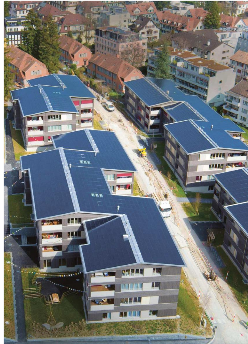
Lotissement de la Balberstrasse © Suntechnics Fabrisolar AG
