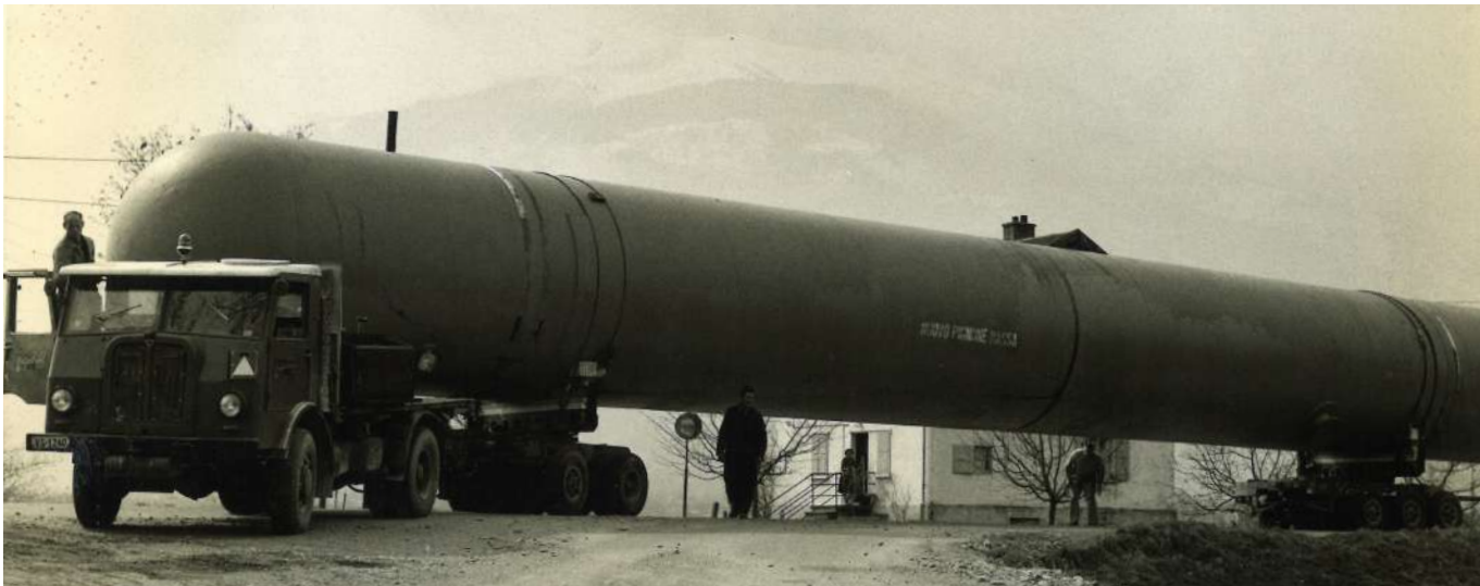
Livraison d'un élément de la tour de distillation, 1960-62, Association Patrimoine Collombey-Muraz
