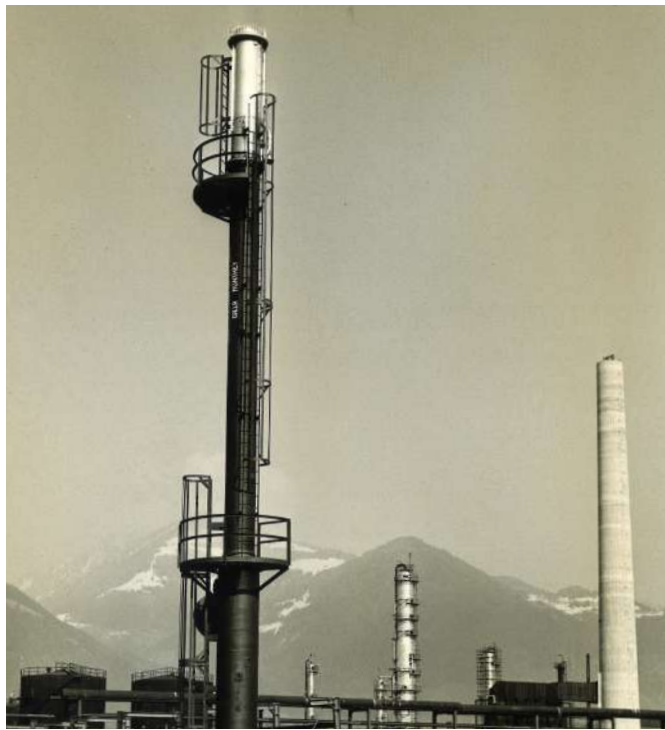
La raffinerie en construction, 1960-62, Association Patrimoine Collombey-Muraz
