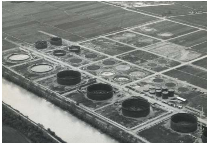
Construction des citernes, 1960, Association Patrimoine Collombey-Muraz
